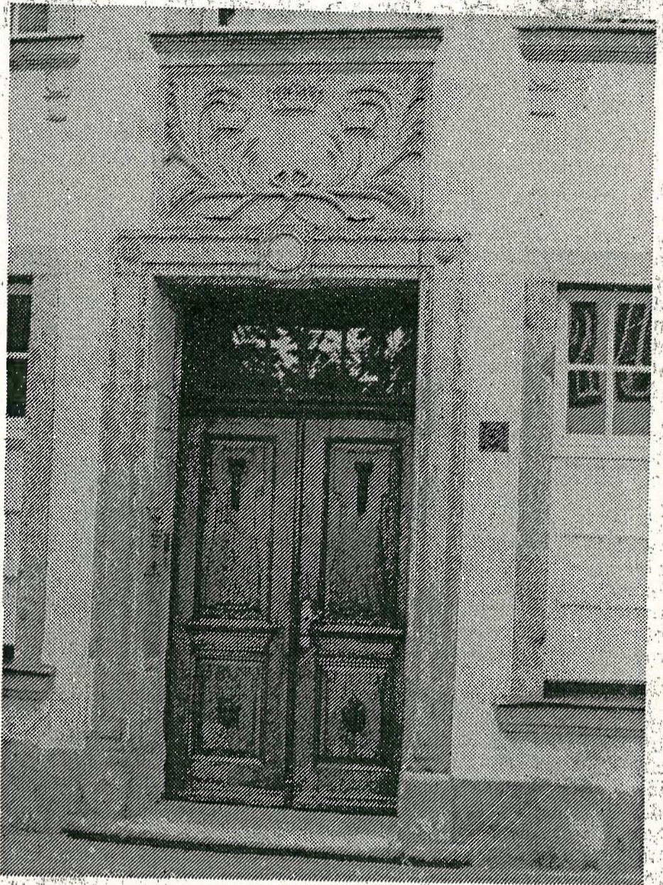
DAS HAUS MARIENSTRASSE 5 war einst ein Gasthof „In den drei Kronen“. Durch Bombenhagel im zweiten Weltkrieg innen ausgebrannt, konnte es dank privater Einsicht im alten Stil erneuert werden. Heute sind hier als Nebenstelle des Museums Gegenstände bürgerlicher Wohnkultur zu finden.
